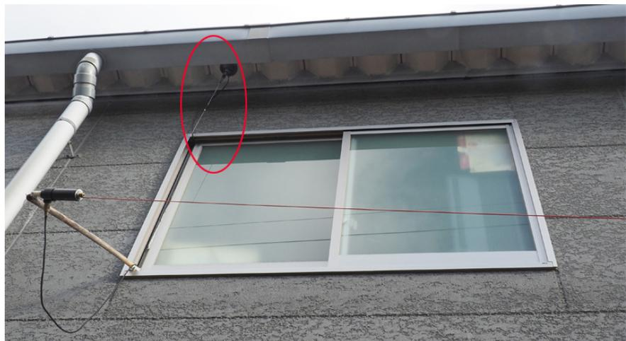
アンテナは部室棟の軒下に設置。144/430MHz 帯のモバイルホイップ (円内) はマグネット基台で固定しています
