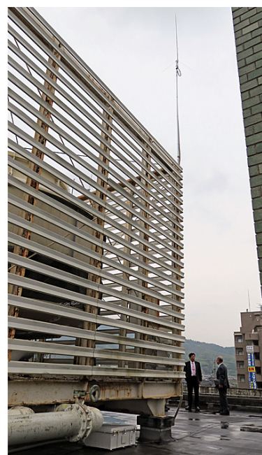
市庁舎2階屋上のクーリングタワー上部にアンテナを設置。
