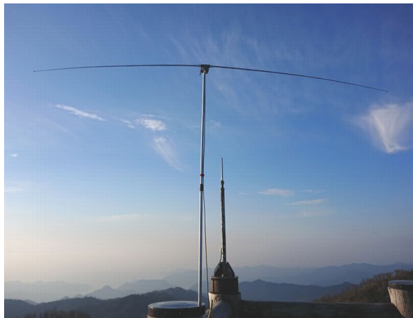
早速ポケットダイポールアンテナを設置
