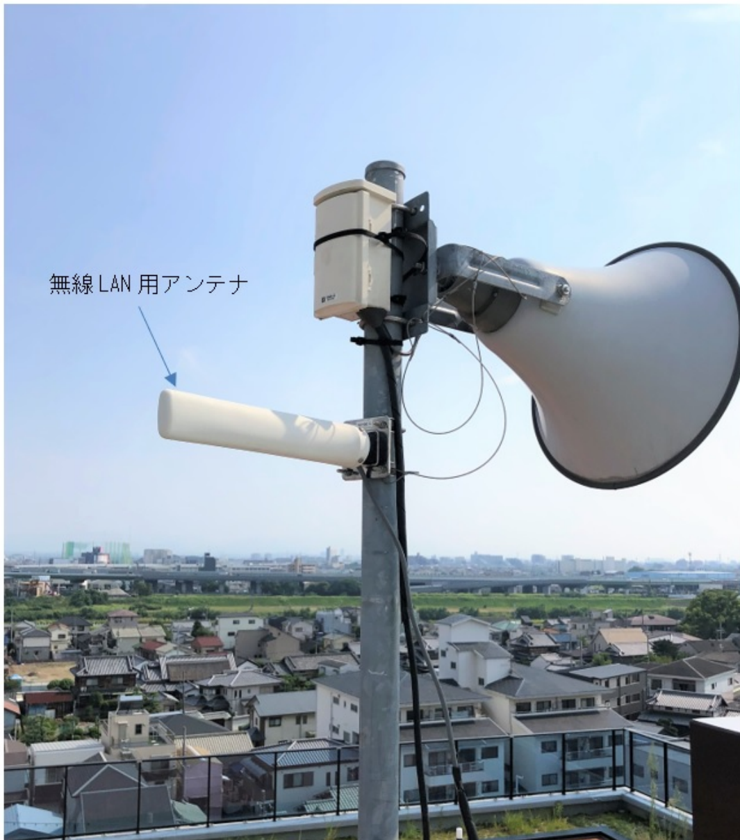
図 1 2.4GHz(802.11b/g)用無線 LAN アンテナの設置例
